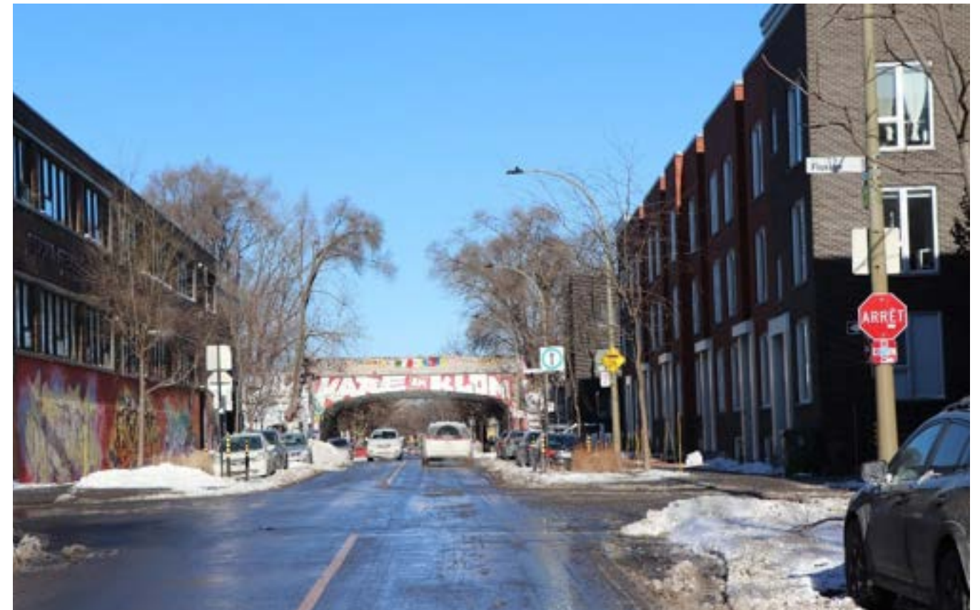
Figure 13 : Le viaduc ferroviaire de la rue de Rouen
