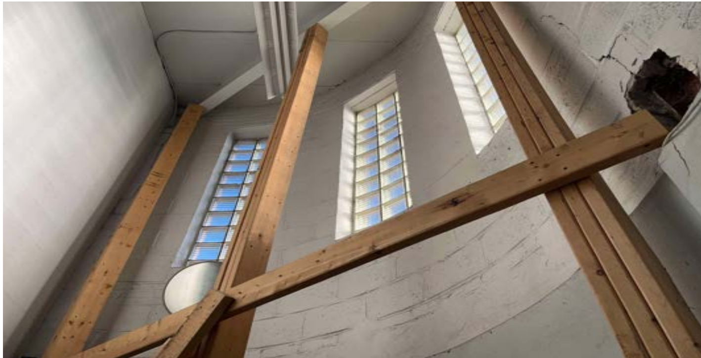
Figure 10 : Les morceaux de bois permettent de soutenir les murs
